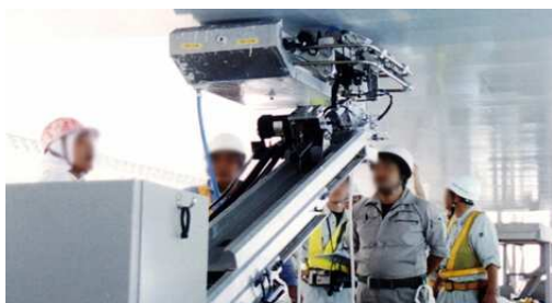
【箱桁塗装ロボット】
